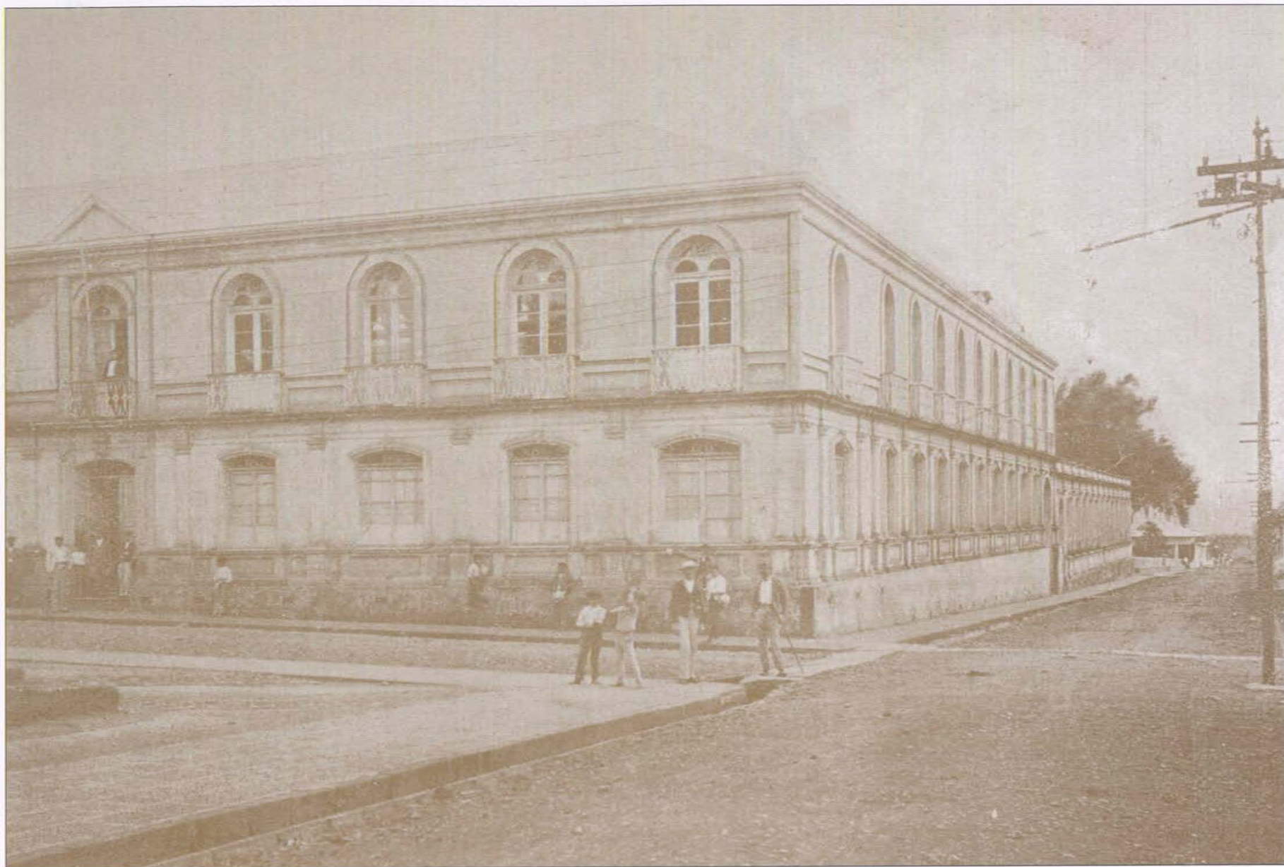
El Instituto de Alajuela, diseñado por el arquitecto Enrique Invernizio, lucía imponente en una ciudad pequeña, en la que prevalecían las edificaciones de una sola planta. El acceso a este colegio, fundado en el contexto de la reforma educativa de la década de 1880 impulsada por los liberales, no se limitó a los jóvenes provenientes de familias acomodadas urbanas, como lo evidencia el caso de Carlos Luis Fallas, quien dejó constancia de su paso por las aulas de este plantel en su extraordinaria novela, Marcos Ramírez (1952). Revista de Costa Rica en el siglo XIX (San José, Tipografía Nacional, 1902), entre páginas 111-113.
